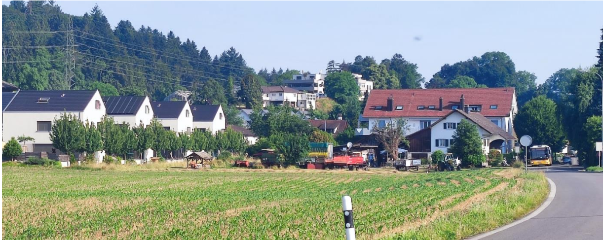
Abbildung 2 Ansicht von Süden auf unbebaute Parzelle 1408 (Quelle: A+W AG)
