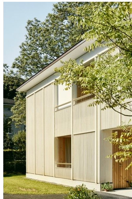
Bürgerheim Arbon Haus Selma - Raumfindung AG
