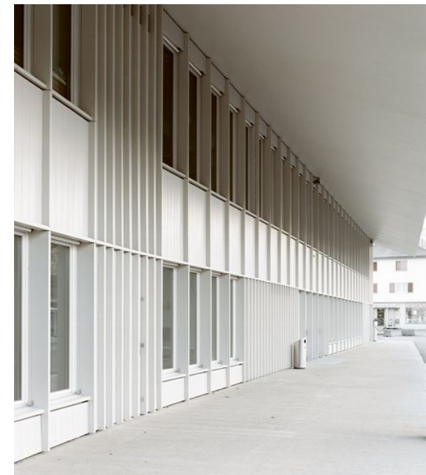
Schulhaus Dietlikon - Baumberger & Stegmeier
