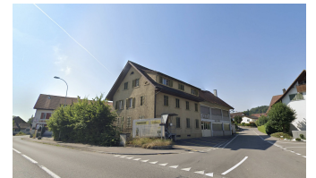
Wohngebäude/Gewerbe Altbau: 15.00-17.00 m
