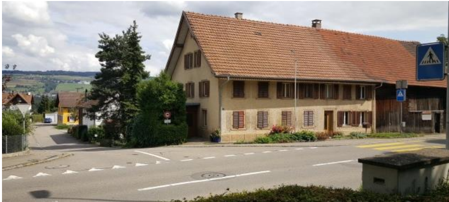
Abbildung 9 Einmündung Hubelstrasse in Hauptstrasse
