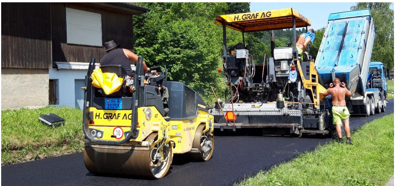
Belagseinbau an der Nesselbacherstrasse im Juni 2019
