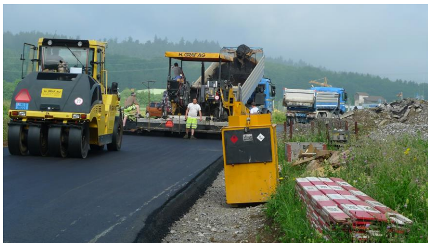
Hochbetrieb während der Bauphase
